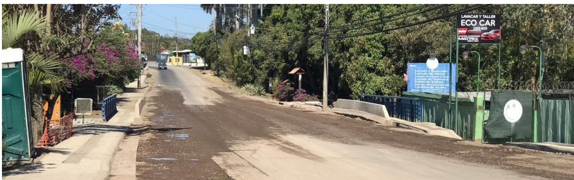
El puente sobre la quebrada Cubillo tiene una avanza del 77%.
