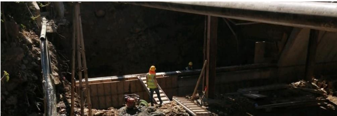
Las labores con cierre serán el martes próximo, de 6 am a 5 pm.
