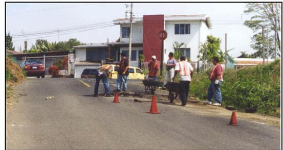
**C.** Dispositivos de control temporal en un trabajo de mantenimiento vial, Costa Rica
