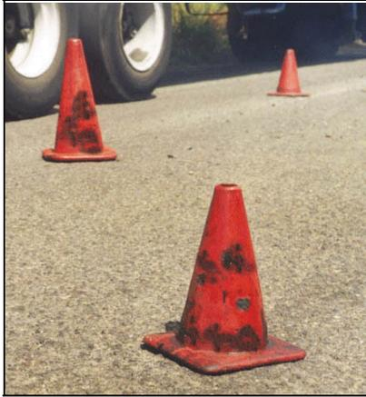
**A.** Sin cinta retroreflectiva y manchados con asfalto
