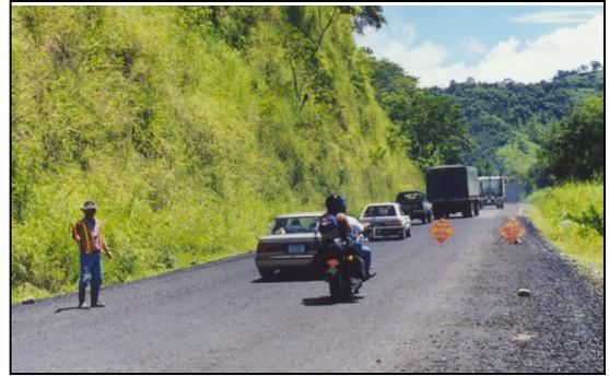
**B.** Control mediante abanderado en un proyecto de reconstrucción vial, Costa Rica
