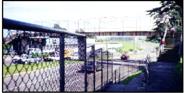
**B.** Empleo típico de mallas para obligar a los usuarios a utilizar el puente peatonal construido sobre una carretera rápida multicarril, Costa Rica
