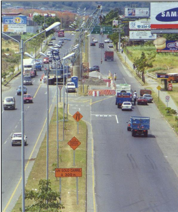
**A.** Dispositivos de control temporal en un área de construcción sobre una vía existente, Costa Rica
