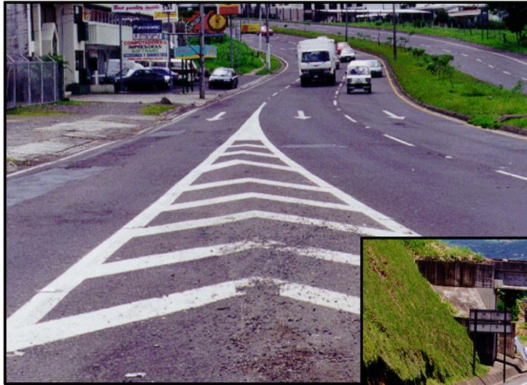
**A.** Rampa de salida con carril de desaceleración paralelo, Costa Rica
