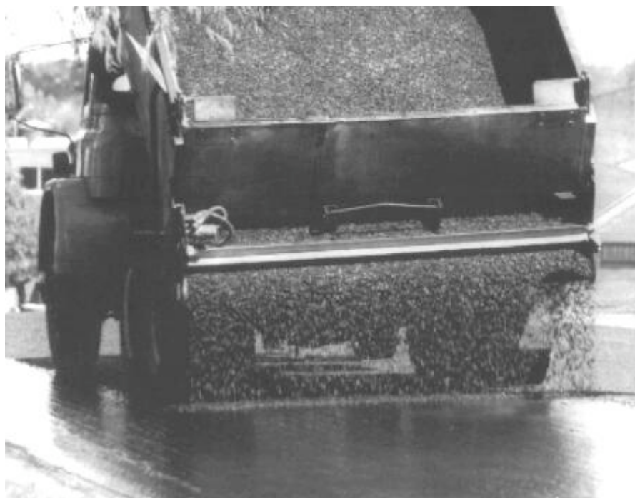
Foto cortesía del Instituto del Asfalto
