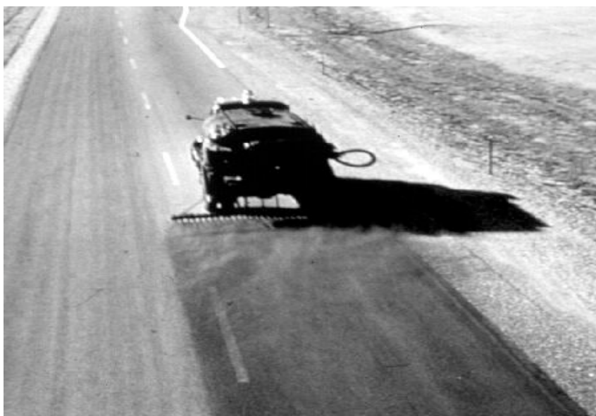
Figura 411.7. Aplicación de un "fog seal"
