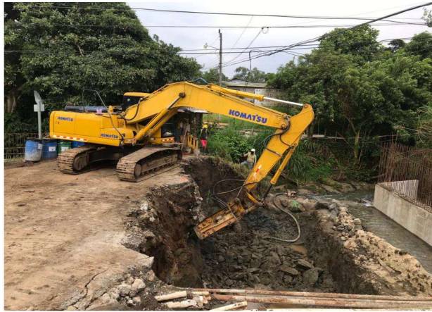
Imagen No.1. Excavación de bastión margen izquierda. Qda. Azul.
