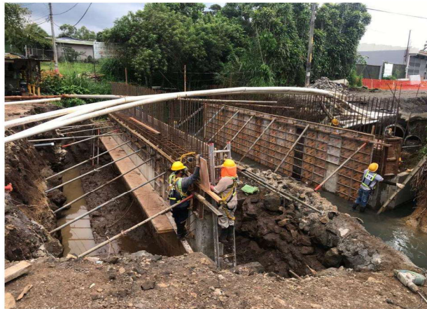
Imagen No.3. Encofrado de faltante de muros de bastión y ménsulas. Qda. Azul.
