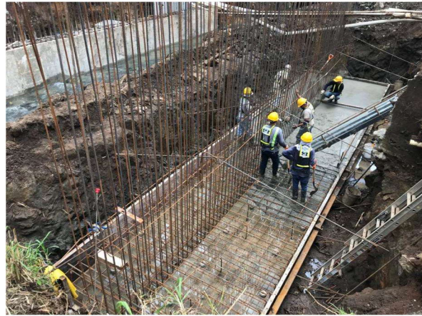
Imagen No.2. Colado de placa de bastión
