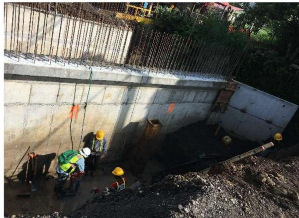
Imagen No.4. Colada de parte de muros y aletones de alcantarilla aguas arriba. Qda Cima.
