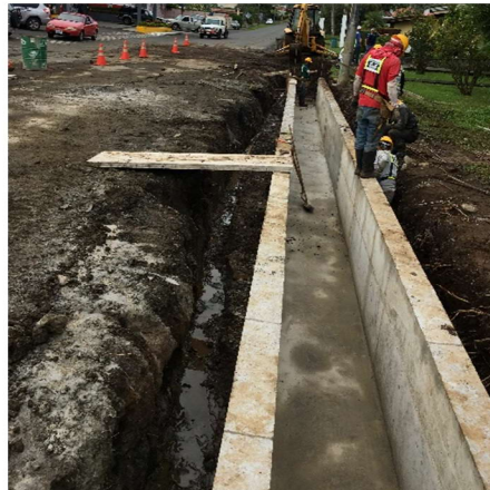
Imagen No.4. Canal de concreto margen izquierda de Qda. Cima. Aproximación.
