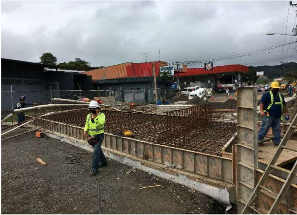
Imagen No.1. Acero de refuerzo, losa superior. Qda. Cima.
