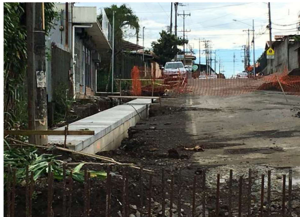
Imagen No.2. Canal de concreto margen derecha de Qda. Azul. Aproximación.
