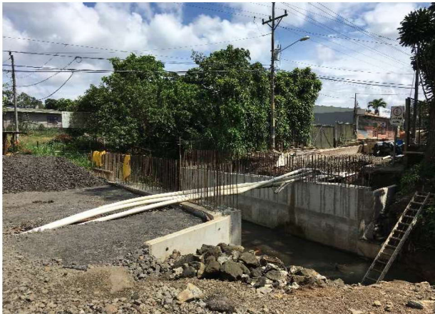
Imagen No.3. Relleno bastión margen izquierda. Qda. Azul.
