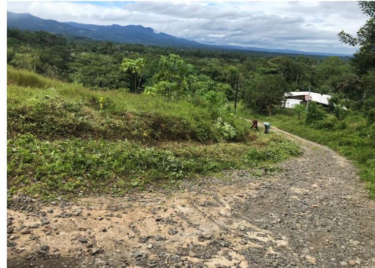
Fotografía 4. Limpieza de sistemas de drenaje y recuperación de derecho de vía
