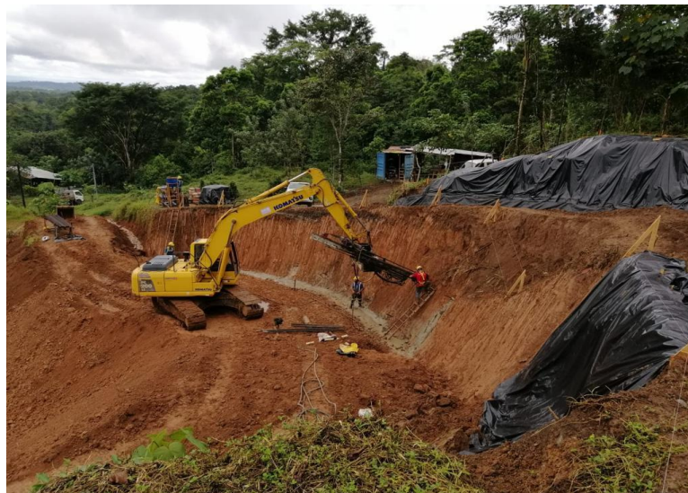
Fotografía 3. Perforación y colocación de anclajes
