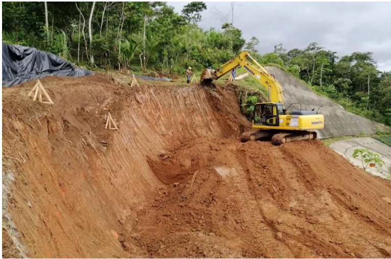
Fotografía 1. Perfilado de talud.
