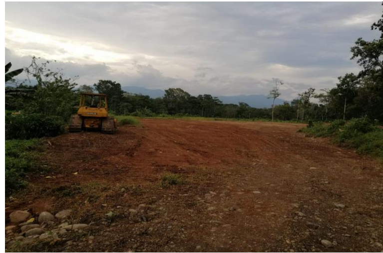
Fotografía 2. Limpieza y remoción de capa vegetal en escombrera
