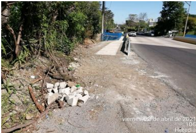
Fotografía 3: Demolición y correcciones en Aceras y cordon y caño
