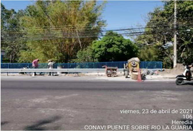
Fotografía 1: Demolición y correcciones en Aceras y cordon y caño
