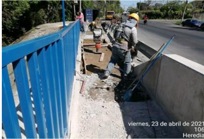
Fotografía 2: Demolición y correcciones en Aceras y cordon y caño
