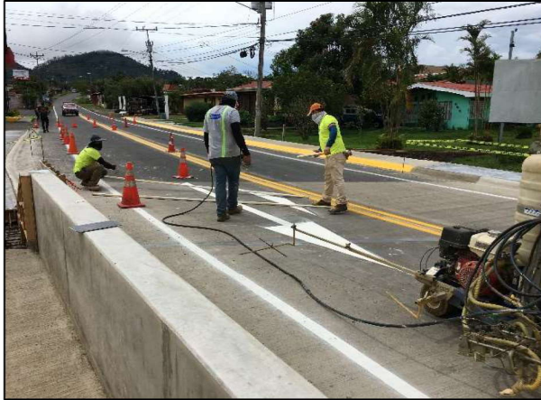
Fotografía 1. Demarcación de señalización vial.
