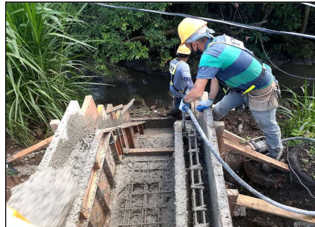
Fotografía 4. Colada de desfogue pluvial de canal. LI de aproximación margen derecha de Qda. Azul
