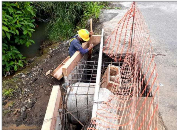
Fotografía 3. Salida de alcantarilla transversal, eje sur.
