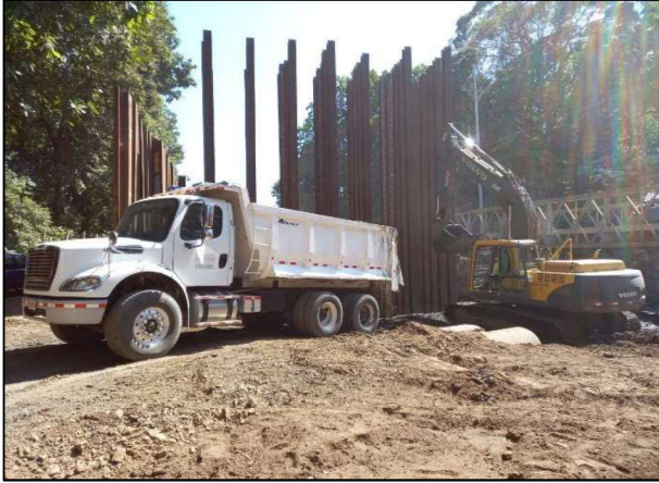
Fotografía N°1. Reacondicionamiento del proyecto. Bastión 2, Puente sobre el Río
