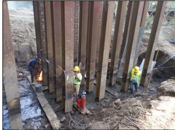
Fotografía N°2. Empalmes de pilotes. Bastión 2, Puente sobre el Río Rempujo
