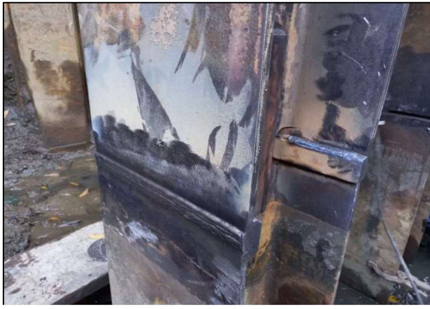
Fotografía N°3. Empalme terminado. Pilote de Bastión 2, Puente sobre el Río Rempujo
