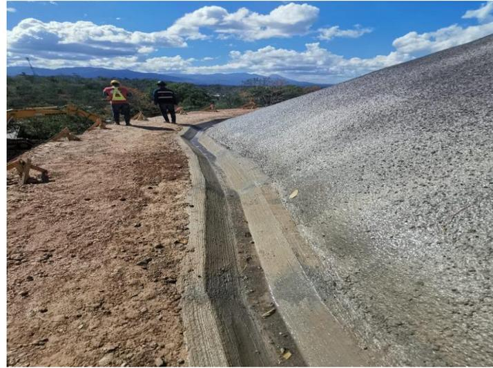
Fotografía 2. Conclusión de obras de drenaje en el talud.
