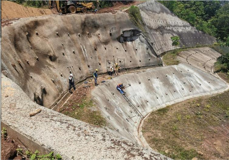
Fotografía 1. Pruebas de tensión de los anclajes.
