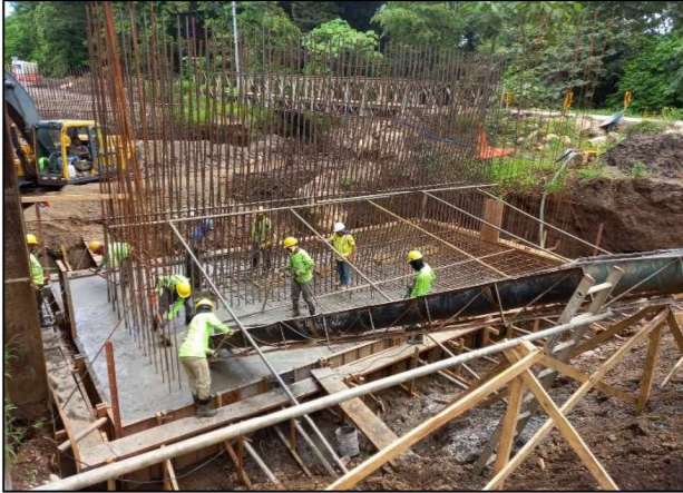
Fotografía N°1. Colada de placa de fundación. Bastión 2, Puente sobre el Río Rempujo
