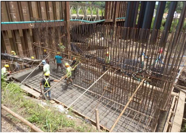
Fotografía N°3. Colada de placa de fundación. Bastión 2, Puente sobre el Río Esperanza
