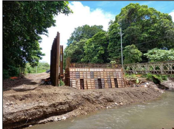
Fotografía N°2. Encofrado de pantalla. Bastión 1, Puente sobre el Río Rempujo
