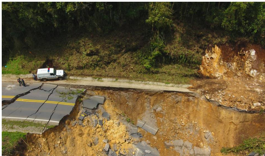
Figura 2. Deslizamiento en el sector de La Cangreja de la Ruta Nacional N.º 2, Cerro de La Muerte. Fuente: La Nación, octubre 2017
