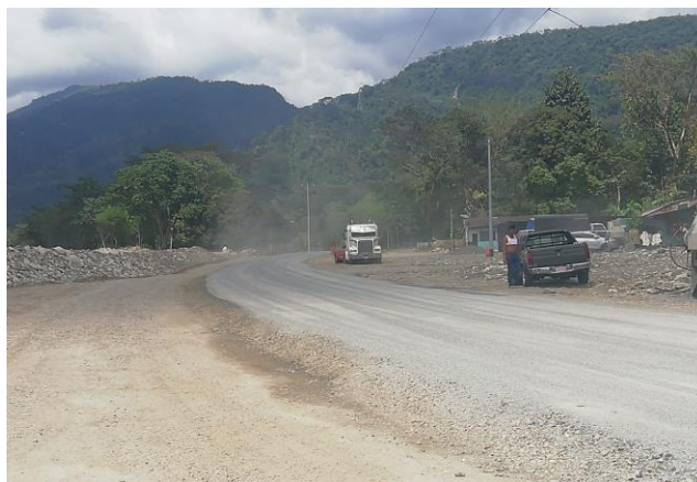
Figura 46. Recuperación del tramo afectado por el río. Fuente: Ing. Gustavo Castro Chaves de la Gerencia de Conservación de Vías y Puentes.
