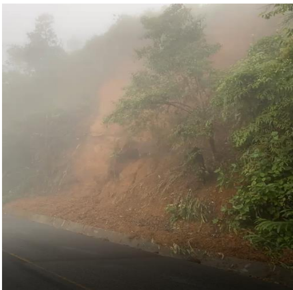
Figura 30. Ruta N.º 243. Tramo San Isidro – Dominical. Derrumbes típicos en la vía. La presencia de una cuneta revestida se considera como una buena práctica constructiva. Se podría mejorar la estabilidad del talud, mediante la construcción de una contracuneta y una adecuación geométrica; sin embargo, estas últimas recomendaciones están en función del derecho de vía disponible. Fuente: aplicación de campo Survey123®, CONAVI 2020.
