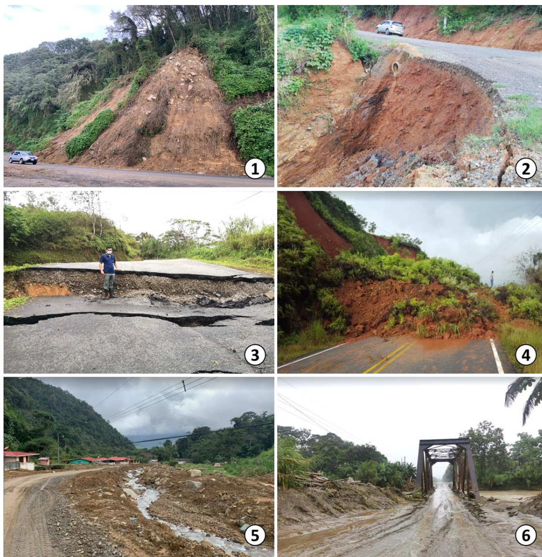
Figura 7. Daños o deterioros provocados por eventos de origen hidrometeorológicos. Fuente: levantamiento de daños en distintas Rutas Nacionales, Survey123®. Periodo octubre – diciembre 2020.
