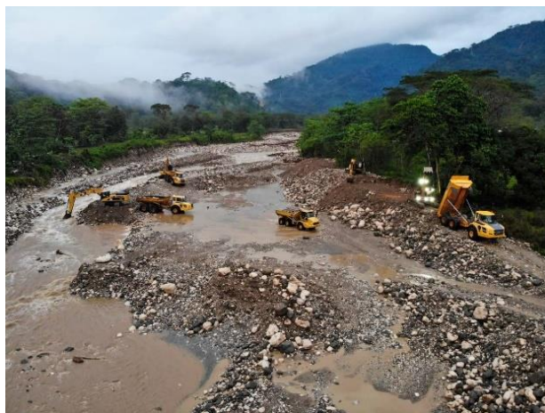
Figura 45. Intervenciones dentro del cauce del río. Fuente: Ing. Gustavo Castro Chaves de la Gerencia de Conservación de Vías y Puentes.
