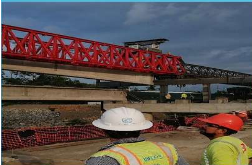
Montaje de Viga No.2 del Tramo No.3
