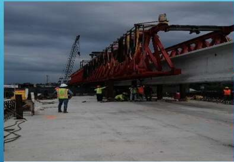
Montaje de Viga No.2 en Lanza Vigas.
