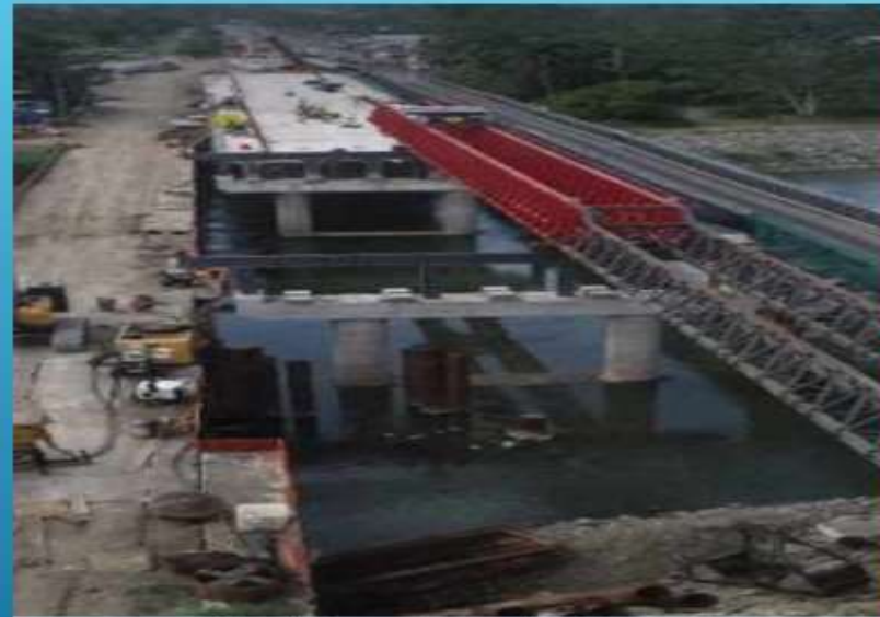
Montaje de lanza vigas entre Pila 3 y Pila 4
