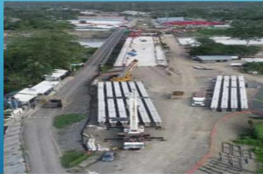
Patio de trabajo Costa Rica, vigas para tramos 3 y 4
