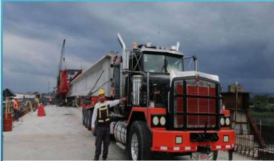
Traslado y montaje de Viga No.2 para Tramo No.3
