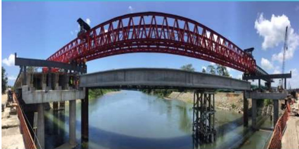
Viga No.1 del Tramo No.3 (de Pila 3 a Pila 4)
