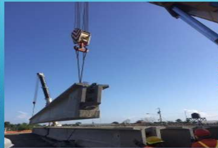
Izaje de Viga No.2 para tramo No.3
