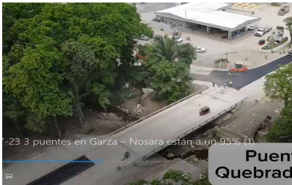
Foto No. 12: Puente sobre Quebrada Sube y Baja, Ruta Nacional No.160
