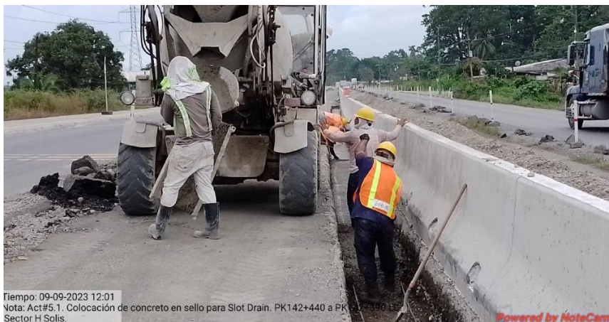
Foto No 4: construcción del cordón de caño y New Jersey
