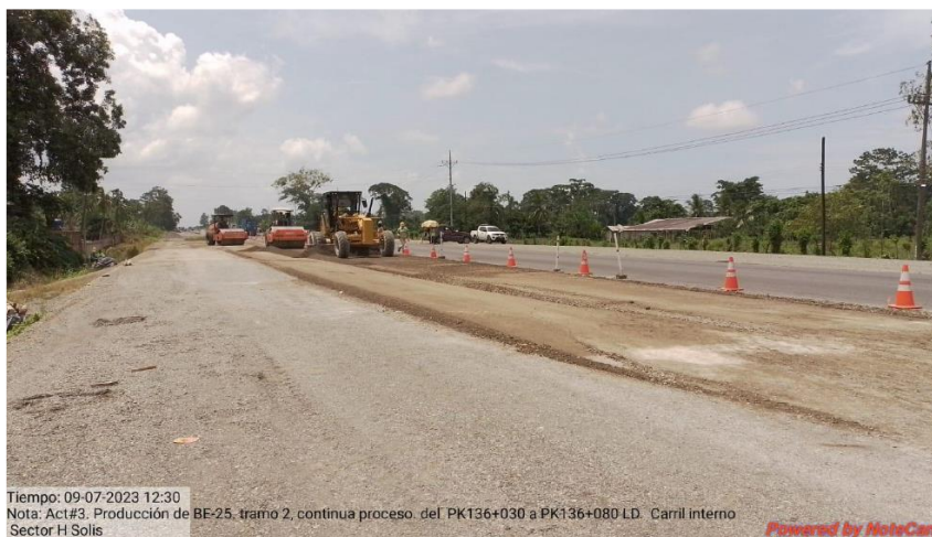
Foto No 1: construcción de la vía
