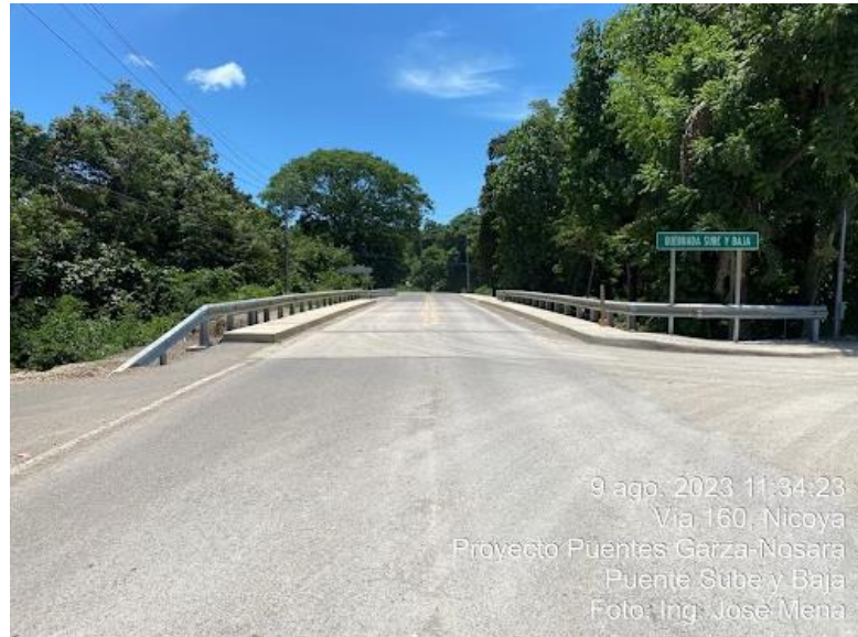
Foto No. 11: Puente sobre Quebrada Sube y Baja, Ruta Nacional No.160
