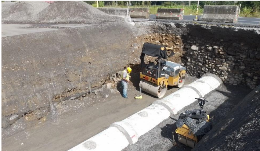
Foto No 3: intercambio y tubería
