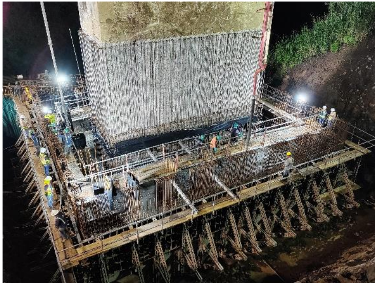
Foto No.36: Colocación de concreto fase 2 para reforzamiento en pila 3
