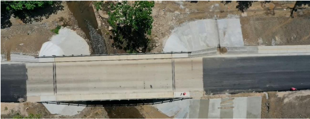
Foto No. 9: Puente sobre el Río Rempujo, Ruta Nacional No.160
