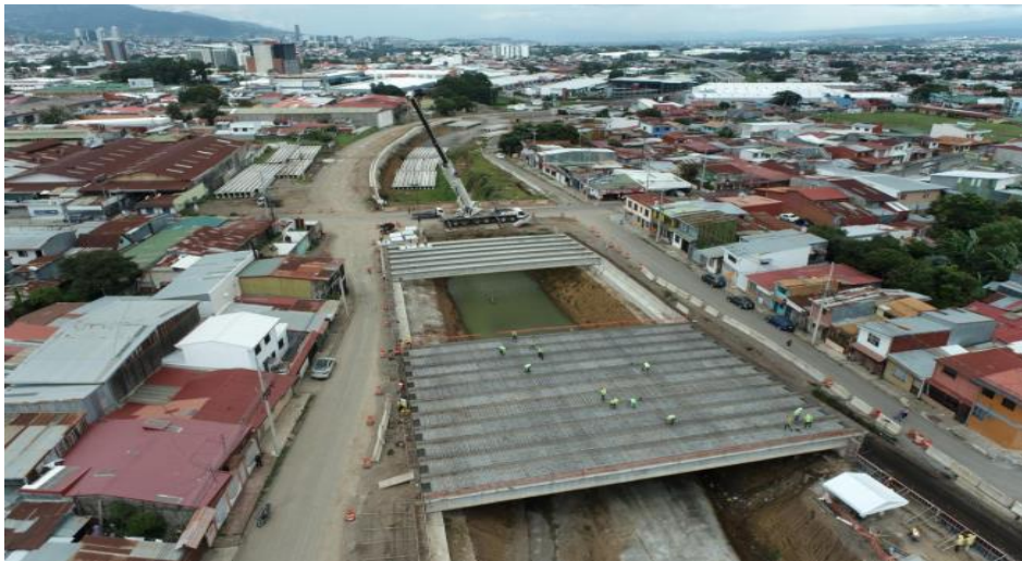
Foto No. 8: Vista aérea del paso deprimido en UF-5
