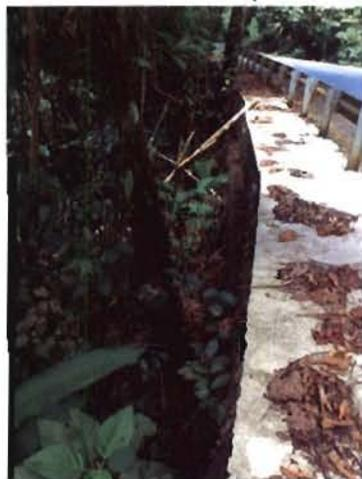
Muro de gaviones, no se observa desplazamiento ni vertical ni horizontal
