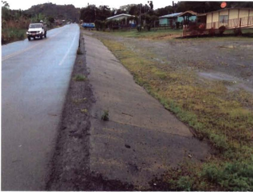
*Figura 10. Revestimiento de taludes de relleno.*
