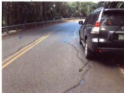
Zona de terreno existente natural (zona de corte) mas dañada que la zona de relleno.
