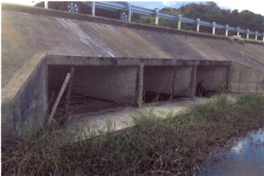
**Figura 4. Alcantarilla triple de concreto km 2, para evitar las inundaciones de las "llenadas" del Rio Rillito y Rio Rincón.**
