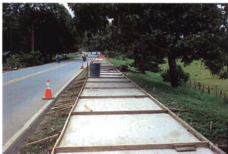
Construcción de aceras a Lepanto
