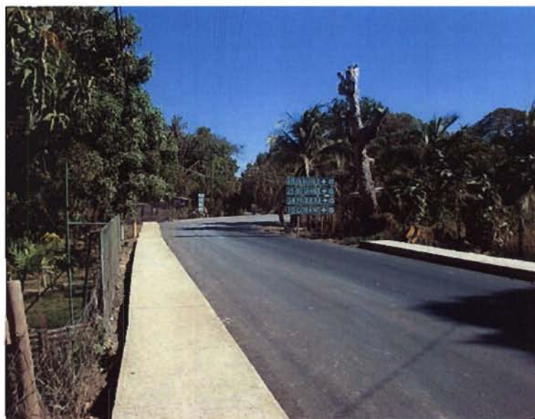
Aproximación al puente Río Lepanto
