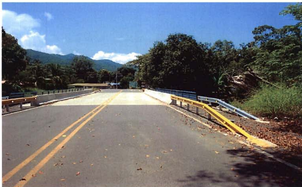
Puente sobre el Río Lepanto
