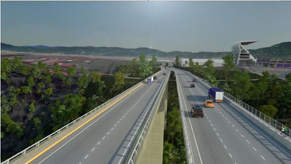
Se ha previsto que el nuevo puente se construya al oeste del existente, es decir aguas abajo del río Virilla, y con una separación entre tableros de 5,50 m.
