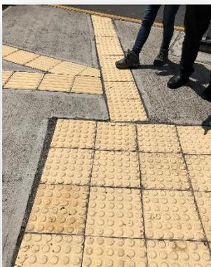
*Exceso y mala colocación de losetas podo táctil, Imagen No. 11 (Fuente C.Serv. Conavi)*
