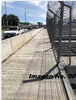
*Falta de loseta podotáctil en el puente peatonal. Imagen No. 40. (Fuente C.Serv. Conavi)*
