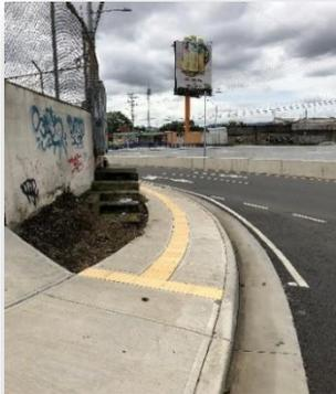
*Inclinación lateral pronunciada y peligro de caída hacia la calle. . Imagen No.19 (Fuente C. Serv. Conavi)*
