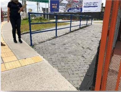
*Ilustración 1 Colocación inadecuada de loseta Imagen No. 9 (Archivo C.Serv. Conavi)*
