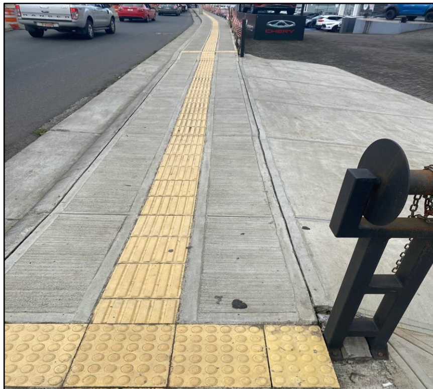
Imagen N°2. Configuración existente de las losas con relieve en las entradas vehiculares en la Unidad Funcional. Fuente: UNOPS
