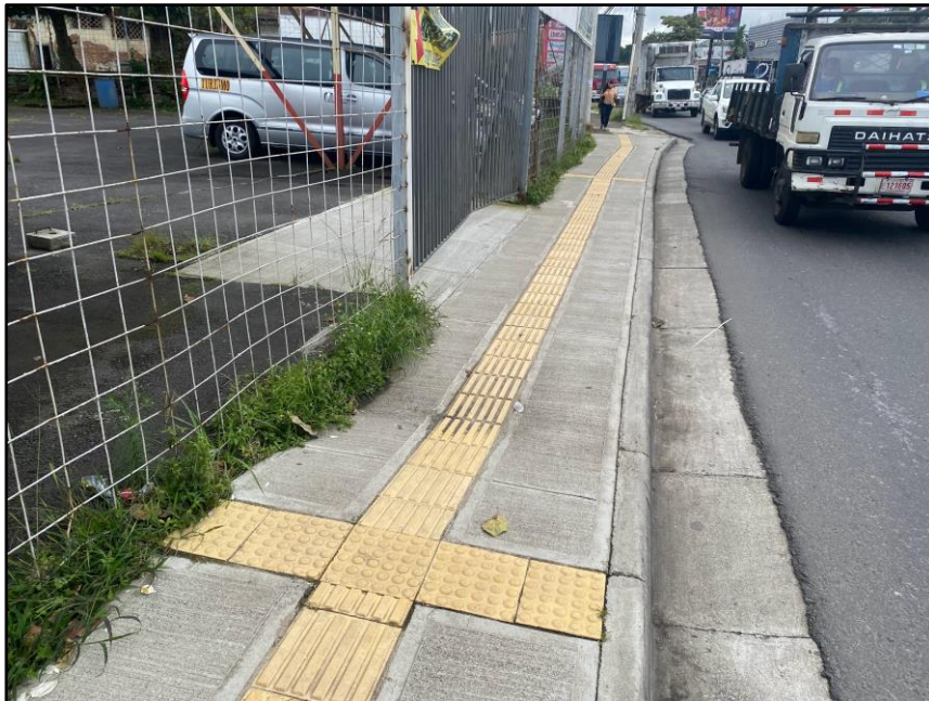
Imagen N°2. Configuración existente de las losas con relieve en las entradas vehiculares en la Unidad Funcional. Fuente: UNOPS
