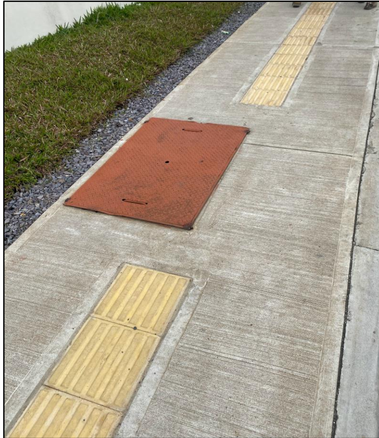
Imagen N°4. Interferencias en la continuidad de la losa con el patrón en relieve para guía.
