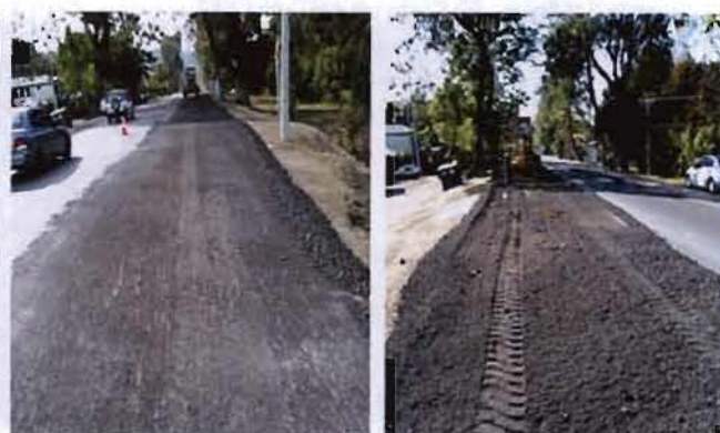
Colocando material perfilado en Ruta 34
