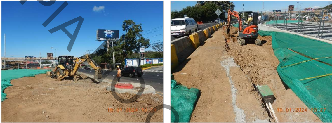
Figura 4. Obras de excavación para colocación de las luminarias del sistema de alumbrado público.
