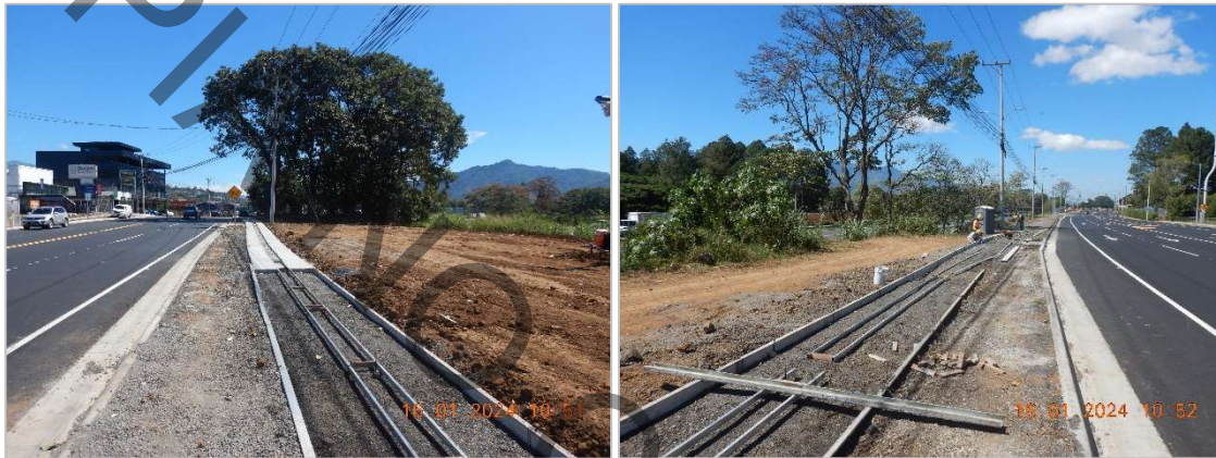
Figura 6. Construcción de aceras en las cercanías de la parada de autobús en Calle Vieja Tres Ríos en sentido La Galera – Calle Vieja.
