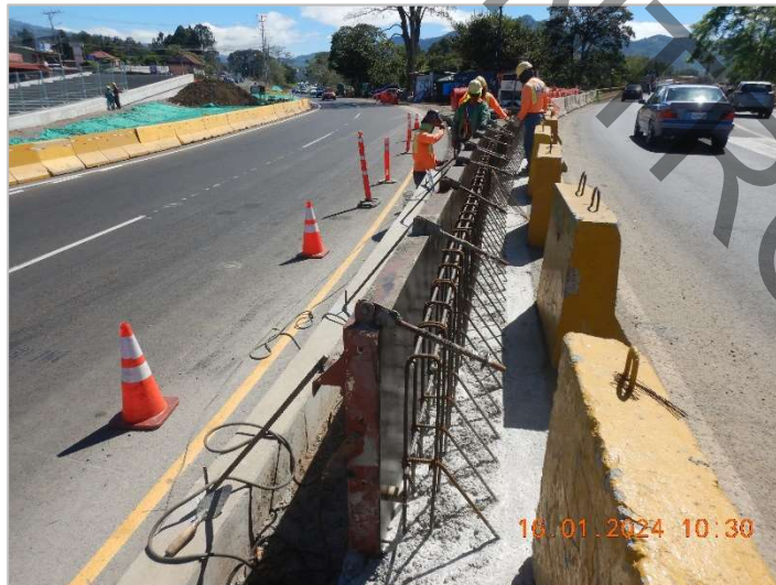
Figura 5. Confección de armaduras para sistemas de contención vehicular rígidos.
